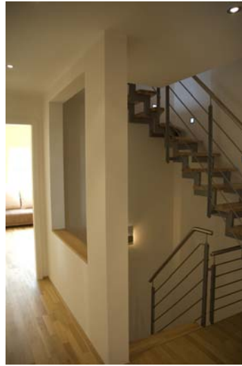
Bild: Treppenhaus eines Referenzobjektes / Stahlbeton mit Holzstufen (Sonderwunsch)
