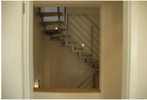
Bild: Treppenhaus eines Referenzobjektes / Stahlbeton mit Holzstufen (Sonderwunsch)
