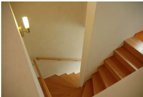
Bild: Treppenhaus eines Referenzobjektes / Stahlbeton mit Holzstufen (Sonderwunsch)
